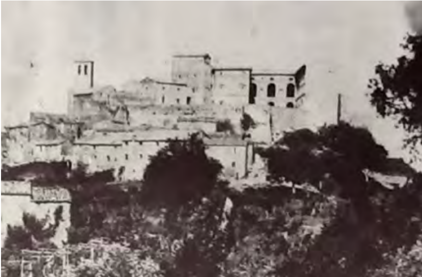
Figura 14. Torre Alfina, il cortile rinascimentale del castello prima degli interventi di Partini, quando erano visibili solo tre assi di finestre (collezione R. Pepparulli).
