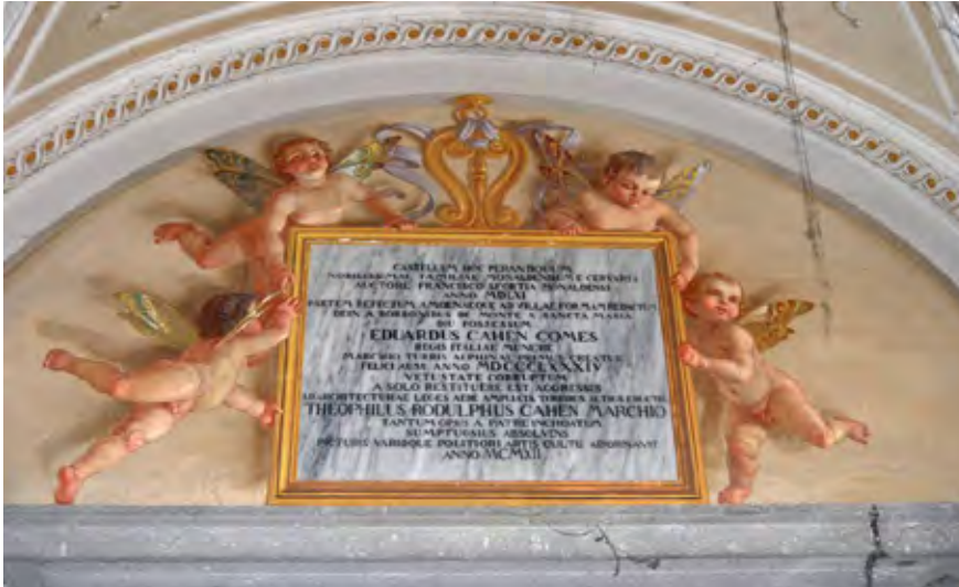
Figura 6. Torre Alfina, castello, iscrizione dipinta al piano terra della galleria che ricorda i passaggi di proprietà del maniero dai Monaldeschi della Cervara, ai Bourbon del Monte di Santa Maria, fino ai lavori architettonici effettuati dal primo marchese Edoardo Cahen (1884) e alle decorazioni pittoriche volute dal figlio Teofilo Rodolfo, 1912 (foto R. Chioveli).
