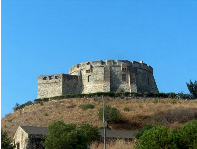
Figura 29. Torre Melissa (KR), la Torre di Torre Melissa dal versante settentrionale, http://www.lovecalabria.com/wp-content/uploads/2014/11/torre_merlata_melissa_2.jpg (ultimo accesso 11 gennaio 2019).
