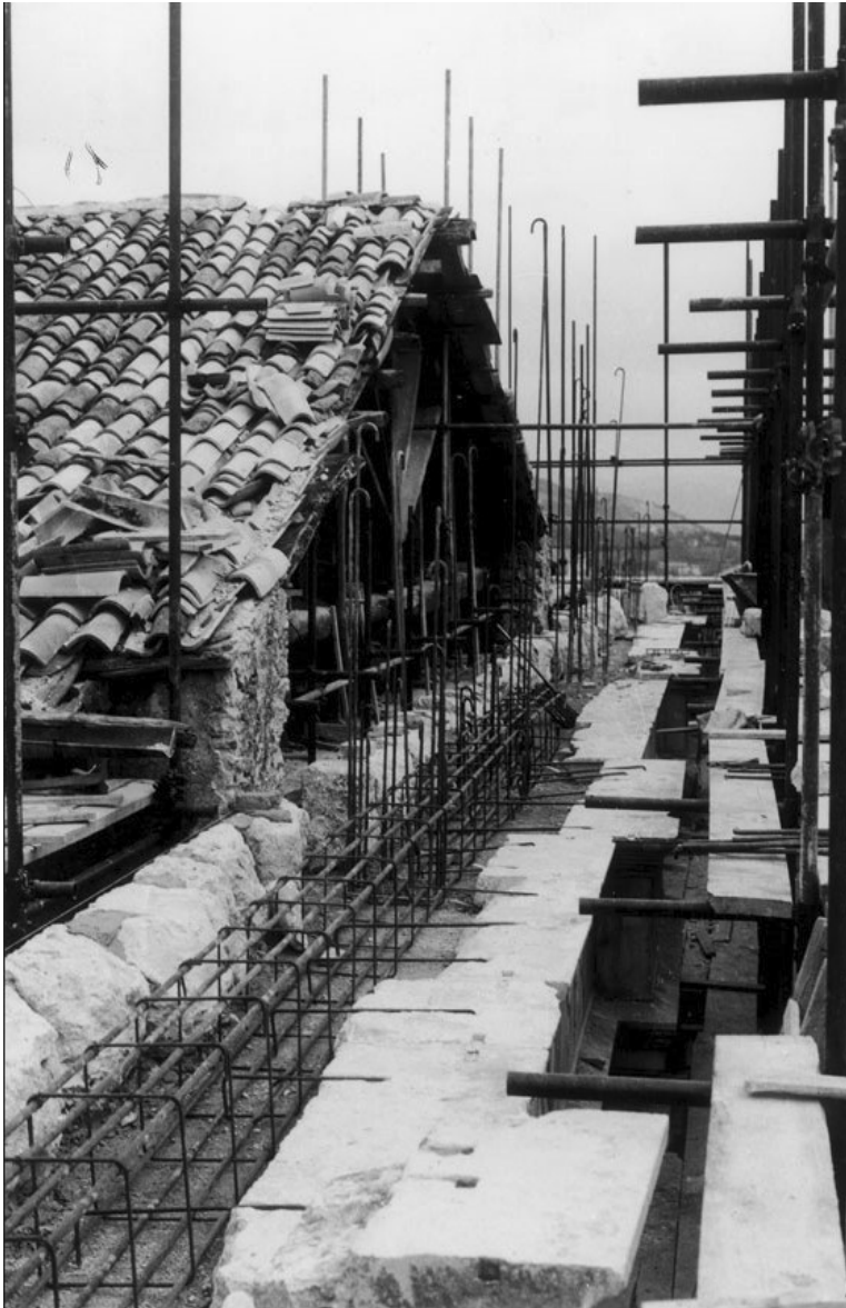
Figura 10. L'Aquila, basilica di San Bernardino, la facciata durante i lavori di ricostruzione. In primo piano le armature del cordolo tra il secondo e il terzo ordine della facciata, con i ferri inseriti nel rivestimento lapideo e ancorati al telaio. In secondo piano si scorgono i ferri verticali per l'armatura dei pilastri e una capriata lignea allora esistente (da https://www.impresacingoli.it/basilica-di-san-bernardino/ ultimo accesso 23 giugno 2023). Per l'uso delle riprese fotografiche, si ringrazia la Direzione Centrale degli Affari dei Culti e per l'Amministrazione del Fondo Edifici di Culto del Ministero dell'Interno, in qualità di Soggetto proprietario.
