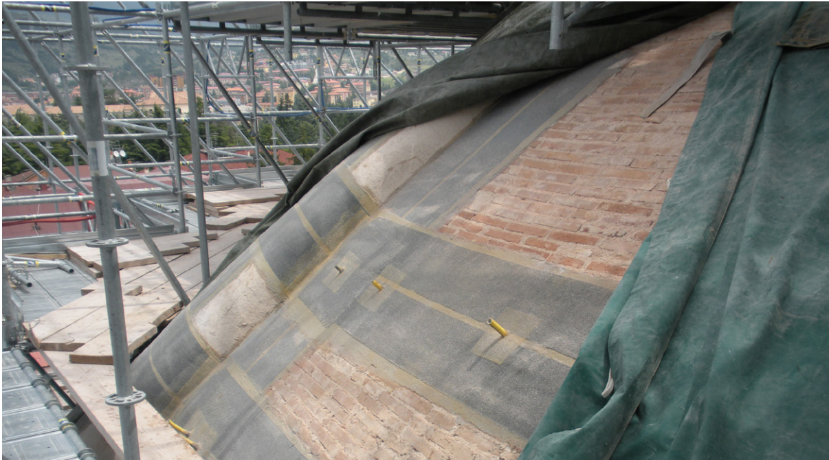
Figura 15. L'Aquila, basilica di San Bernardino da Siena, la cupola durante i lavori di consolidamento dopo il sisma del 2009. Si vedono i costoloni in pietra e la muratura in mattoni (foto C. Bartolomucci, 2011). Per l'uso delle riprese fotografiche, si ringrazia la Direzione Centrale degli Affari dei Culti e per l'Amministrazione del Fondo Edifici di Culto del Ministero dell'Interno, in qualità di Soggetto proprietario.
