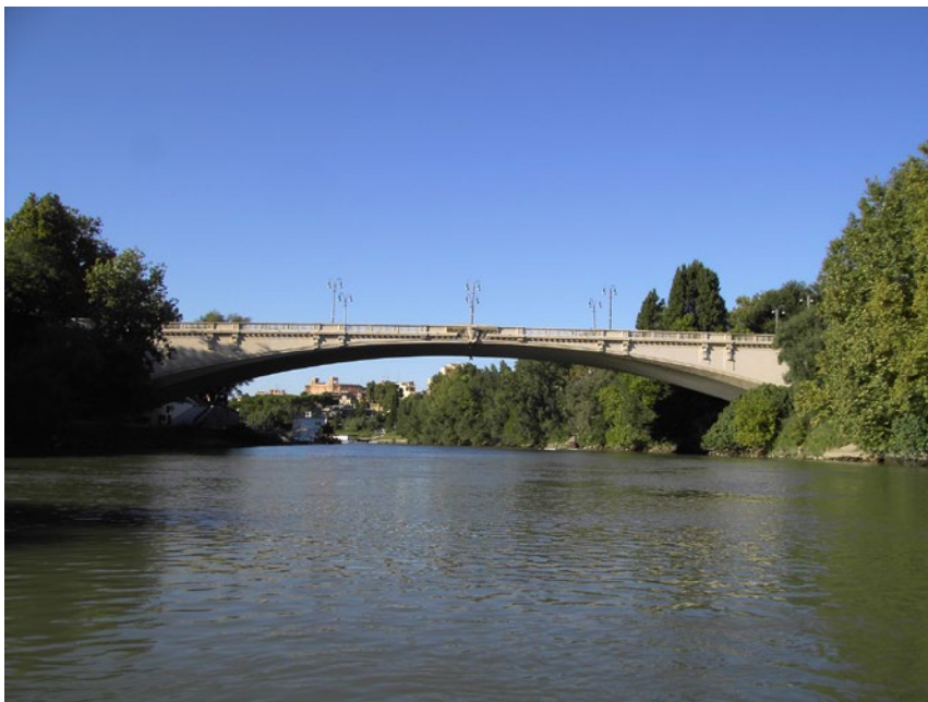
Figura 1. Roma, ponte Risorgimento, Giovanni Antonio Porcheddu con François Hennebique, 1909-1911, vista attuale ( https://it.wikipedia.org/wiki/Ponte_del_Risorgimento_(Roma)#/media/File:Tevere_-_PonteRisorgimento1.JPG , ultimo accesso 10 luglio 2023).
