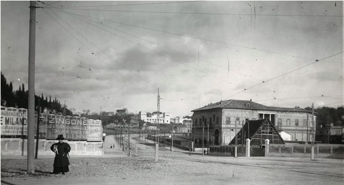
Figura 2. Roma, piazzale delle Belle Arti nel 1915, prima della realizzazione dei due blocchi residenziali di Ettore Rossi e Giulio Gra (cartolina, primi anni del Novecento).
