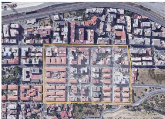
Fig. 1 - Vista dall'alto dell'area di intervento. (fonte: Google EarthTM)
